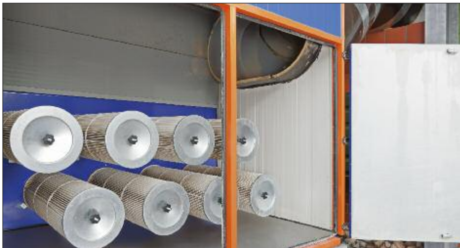
Filtereinheit aus Zellulose sorgt dafür, dass nur gereinigte Abluft aus dem Stall in das Tauscherpaket gelangt
