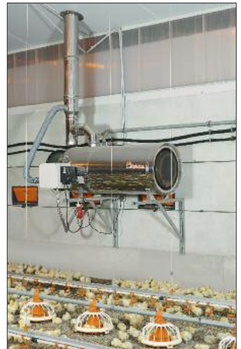
RGA 100 – Gasheizgerät mit Schornstein
