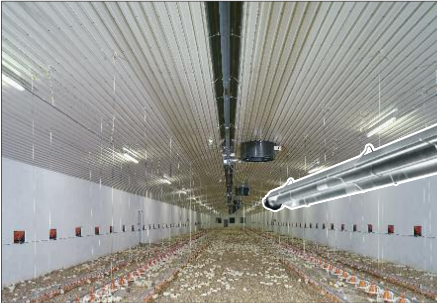
Einsatz des Dunkelstrahlers im Hähnchenmaststall
