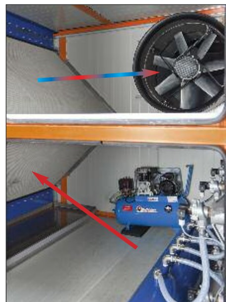
Gereinigte Abluft wird angesaugt (unten) Vorgewärmte Frischluft gelangt in den Stall (oben)
