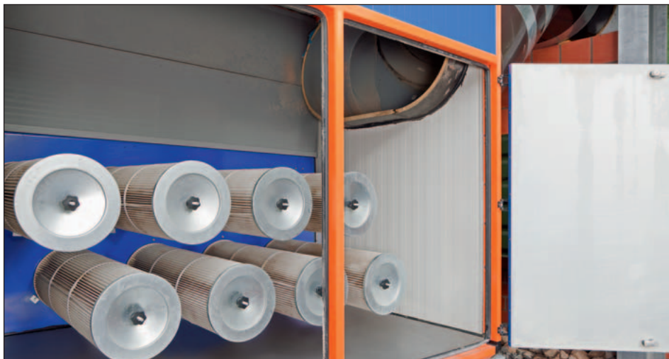
Komplet filtrów z celulozy zapewnia, że z kurnika do wymiennika ciepła dostaje się wyłącznie oczyszczone powietrze zużyte
