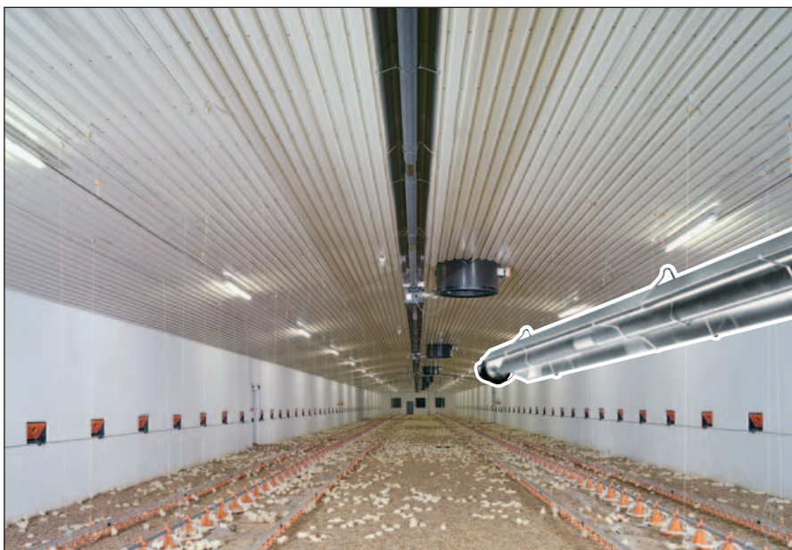
Zastosowanie promiennika podczerwieni w kurniku dla brojlerów
