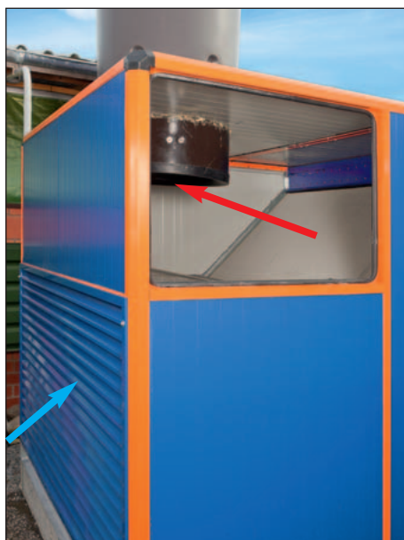
Doprowadzanie świeżego powietrza i powietrze zużyte, które jest odsysane z wymiennika ciepła
