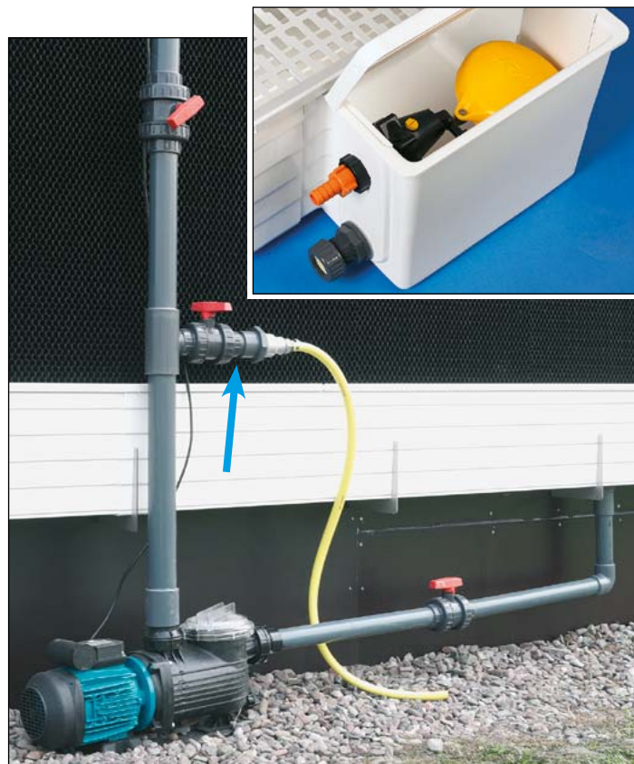
Центробежный насос включ. фильтр и отвод
