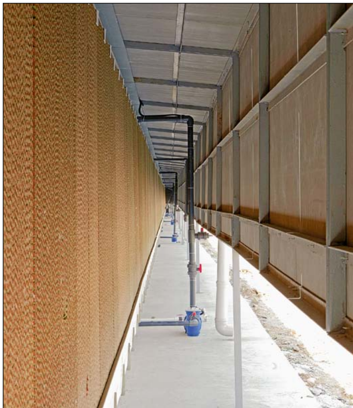
Защита от ветра и пыли, отсутствие прямого воздействия солнечных лучей на волокно
