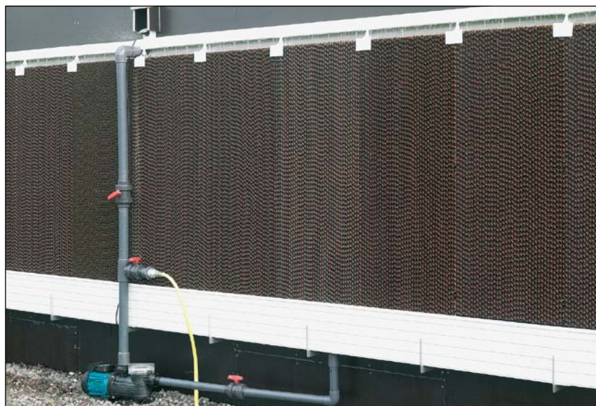
Центробежный насос включ. фильтр и отвод
