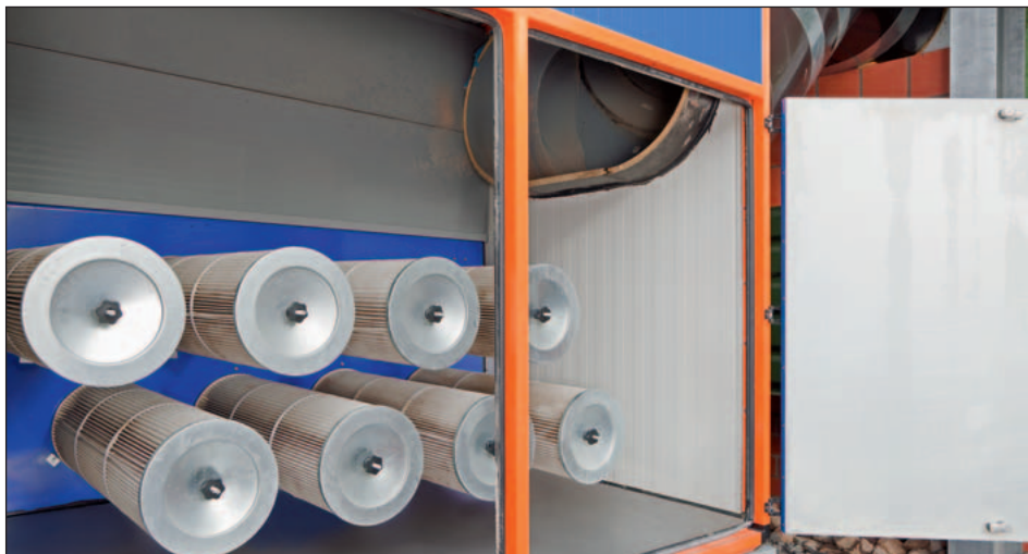
Фильтр из целлюлозы гарантирует поступление в теплообменник только очищенного отработанного воздуха
