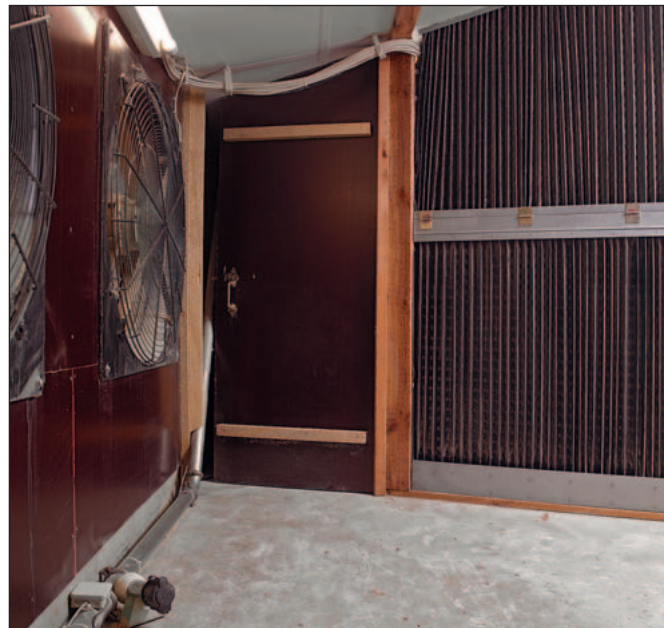
Обратная сторона фильтра: отработанный воздух вытягивается вентиляторами через фильтр
