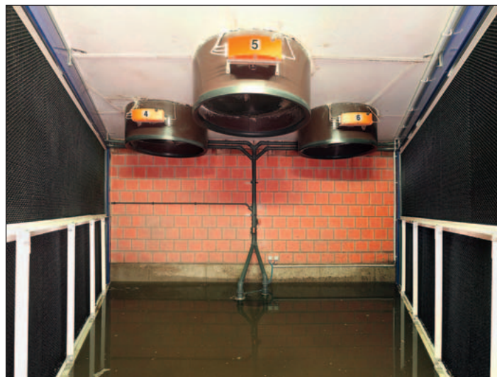
Обратная сторона фильтра – вытяжные камины через фильтр выводят воздух из помещения
