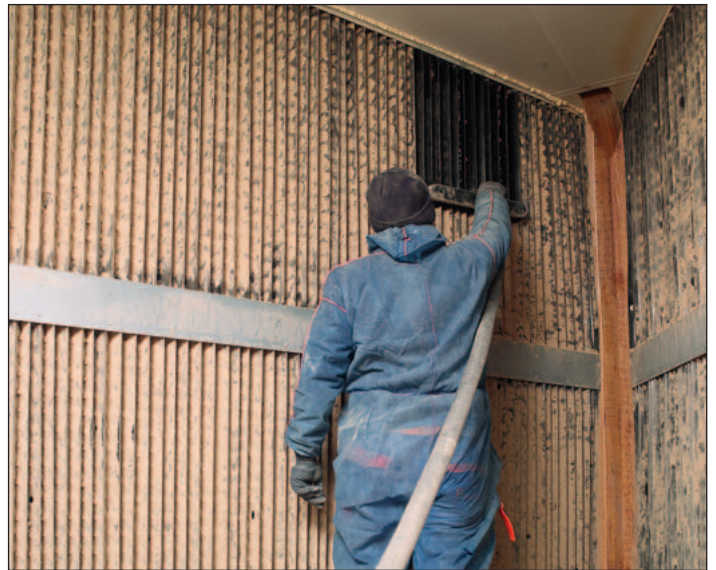
Чистка фильтра щеткой
