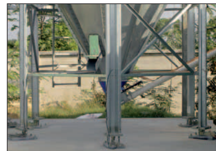
Взвешивание бункера электронными тензодатчиками
