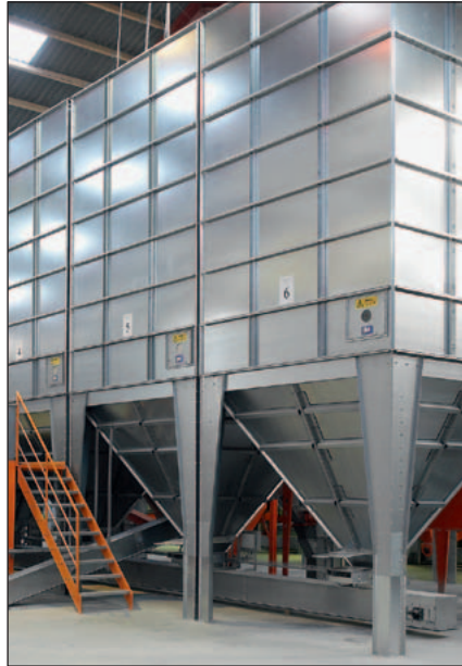
Innensilos zur Lagerung der fertigen Mischung
