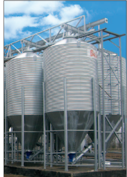
Außensilos zur Lagerung der Rohkomponenten
