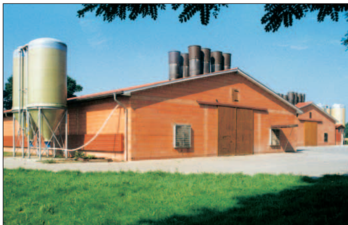
Централизованная вытяжная вентиляция
