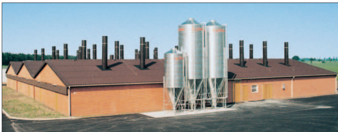
Децентрализованная вытяжная вентиляция
